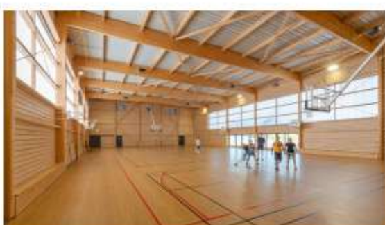
GYMNASE Bruyères le Châtel (91)
