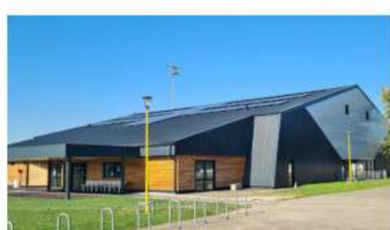
RÉNOVATION TENNIS COUVERTS La Wantzenau (67)
