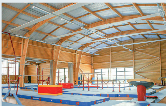
SALLE DE GYMNASTIQUE AVIO® Argentan (61)
