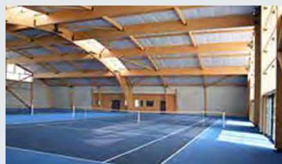
09/09 Halle de tennis à Châteauneuf sur Loire (45)
