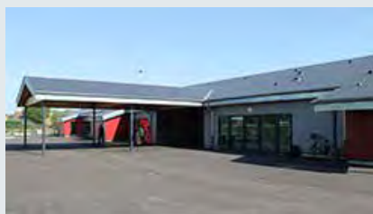
02/09 Groupe scolaire à Vernouillet (78)
