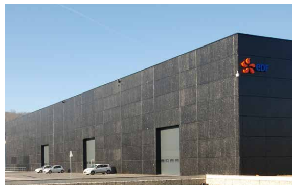
Plateforme de stockage EDF à Velaines (55) - 42 400 m 2 Architecte : RTR Architectes
