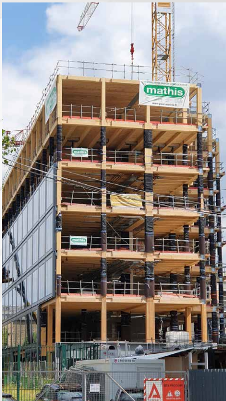
Immeuble Stream Building à Paris (75) - 13 200m 2 Promoteur : Covivio Architecte : PCA STREAM Philippe Chiamberetta
