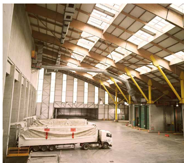
Centre de valorisation énergétique à Halluin (59) - 19 000 m 2 Architecte : Cabinet Urba Linéa
