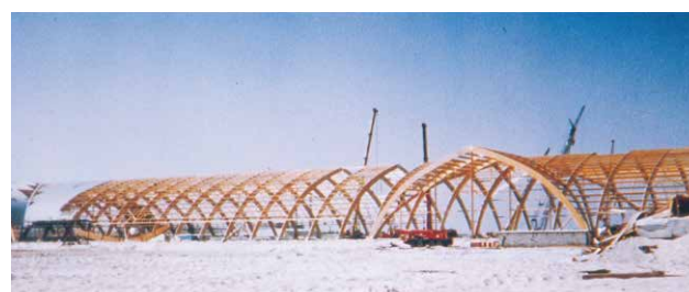
Stockage de soufre aux Emirats Arabes Unis - 40 000 m 2 Client : ADNOC
