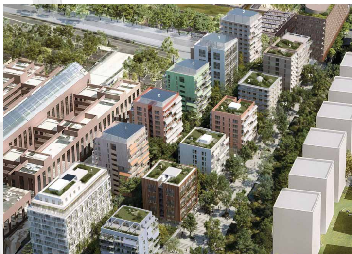
7 immeubles du village olympique. Chantier en cours (93)
