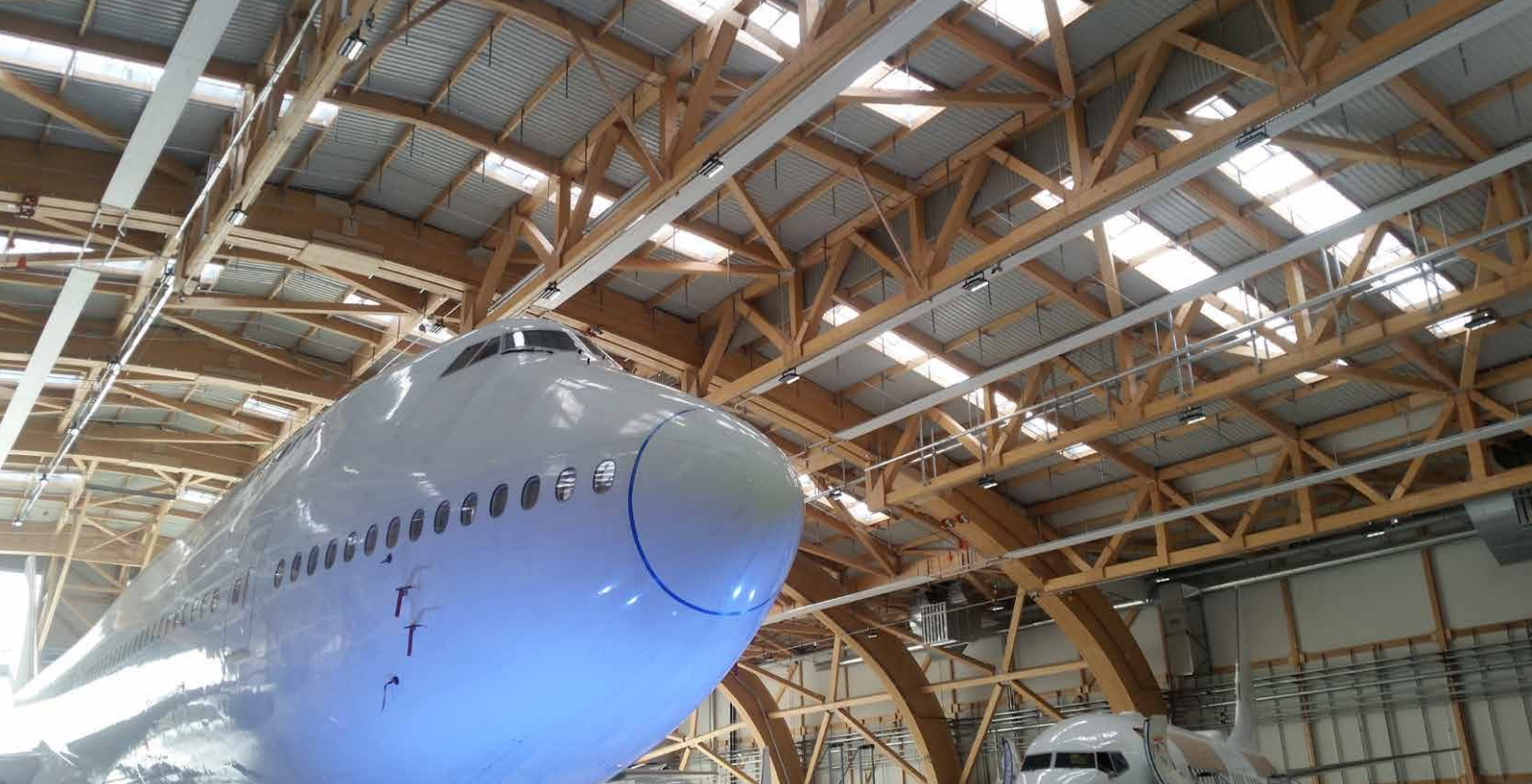
Hangars de maintenance gros porteurs pour Jet Aviation à l'Euroairport de Bâle-Mulhouse - 18 000 m 2
