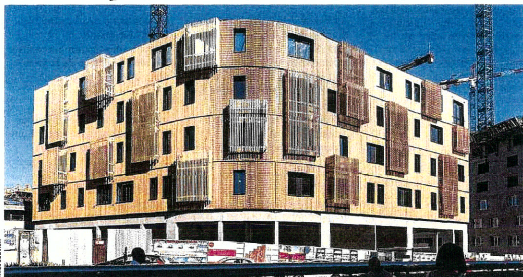
Le siège de Nexity, à Marseille, sera le plus haut immeuble de bureaux en structure bois massif dans l'Hexagone.
