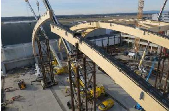
La demi-arche de 45 tonnes est soulevée par deux grues pour s'insérer au centimètre près sur ses ferrures de pied. Chaque arche est longue d'une centaine de mètres. Le chantier a essuyé des vents de 125km/h, début janvier...
