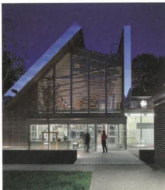
▲ L'entrée du gymnase
