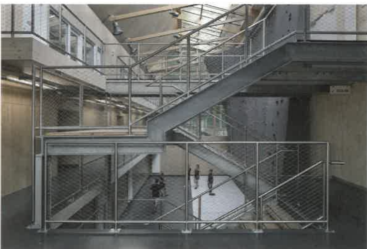
▲ L'accès aux espaces d'activité se fait par un système de circulations en balcon.
