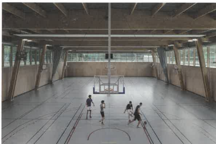
▲ Semi-enterrée dans une cuve en béton, la salle omnisports est ponctué par des portiques en bois lamellé-collé de 25 m de portée reposant sur des poteaux doubles, également en lamellé-collé.
