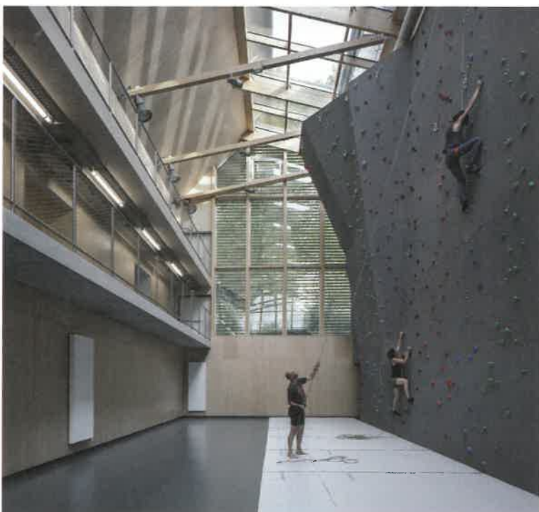
▲ Au-dessus du mur d'escalade, la toiture combine une charpente en lamellé-collé et des panneaux CLT.
