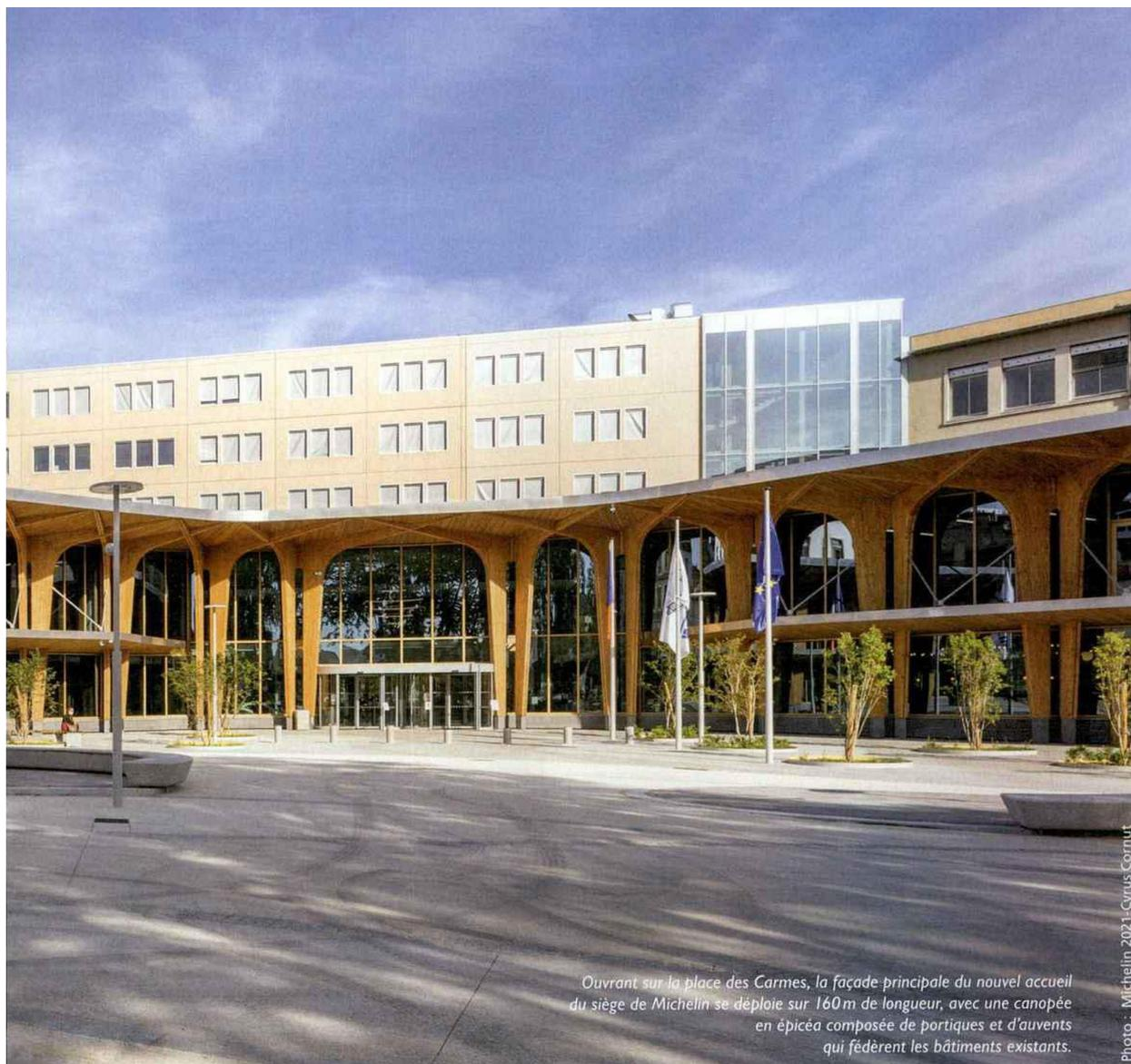
Ouvrant sur la place des Carmes, la façade-principale du nouvel accueil du siège de Michelin se déploie sur 160 m de longueur, avec une canopée en épicea composée de portiques et d'auvents qui fédèrent les bâtiments existants.
