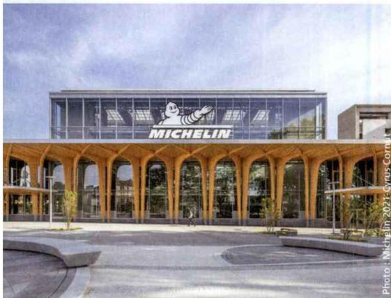
▲ Insérée dans la façade, la boîte de la serre tropicale de 20 m de hauteur et 40 m de largeur, sorte d'emblème de la manufacture, a été relookée, avec de nouveaux murs-rideaux et une couverture en charpente acier revêtue de polycarbonate.
