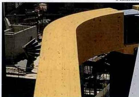
La courbure des façades est obtenue par des poutres cintrées constituées de lamelles inférieures à 4 cm, pour des rayons de courbures atteignant 1,73 m. Elles supportent des planchers CLT en bois massif vissés par le dessus. Dans les angles, les panneaux BBS125 sont remplacés par des panneaux XL. ■
