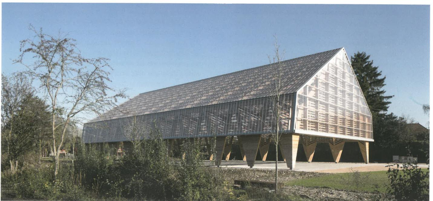
▲ Le toit en polycarbonate, sans chéneau, renvoie l'eau à plus d'un mètre des bardages jointifs qui doivent également dissuader les grimpeurs.
