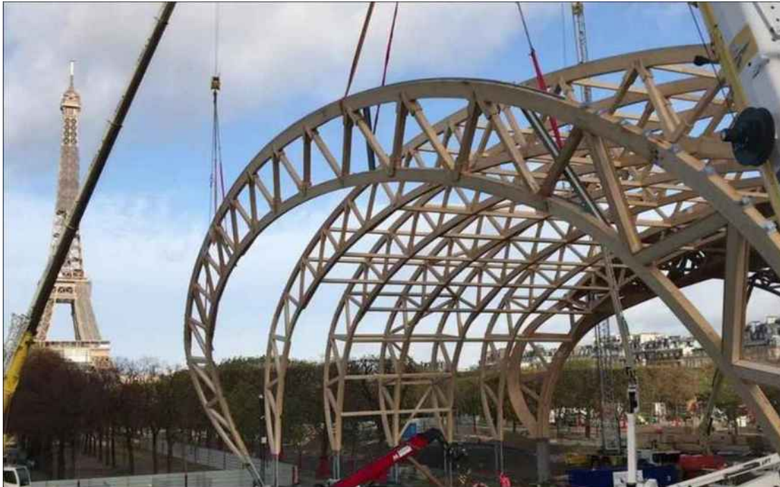
L'entreprise Mathis intervient sur le chantier du Grand Palais éphémère. Photo MATHIS
