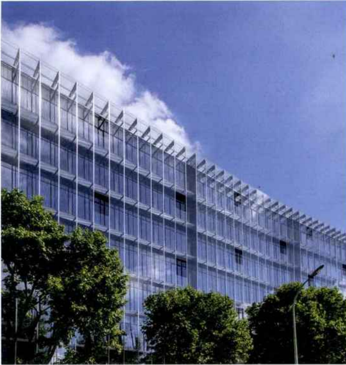
▲ La façade nord est traitée en double peau. Elle forme un filtre acoustique pour pallier les nuisances sonores.
