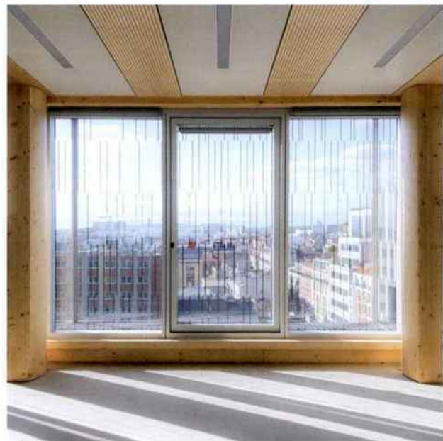
▲ La structure porteuse en bois est volontairement laissée apparente dans les bureaux.
