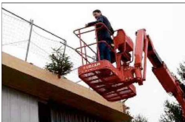
DANS LES AIRS. Christian Mauchien a déposé le sapin au sommet de la charpente.
