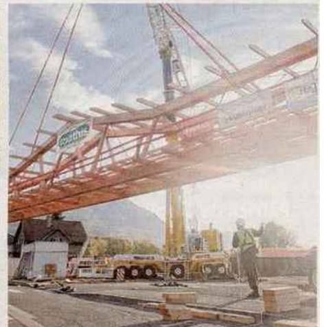
Une grue de 750 tonnes a été utilisée pour lever la passerelle.
