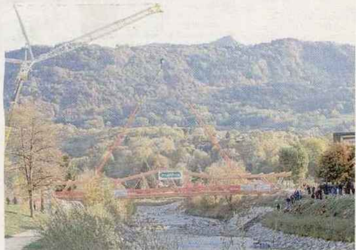
Avec cette nouvelle passerelle, c'est un nouveau paysage qui s'offre aux passants.
