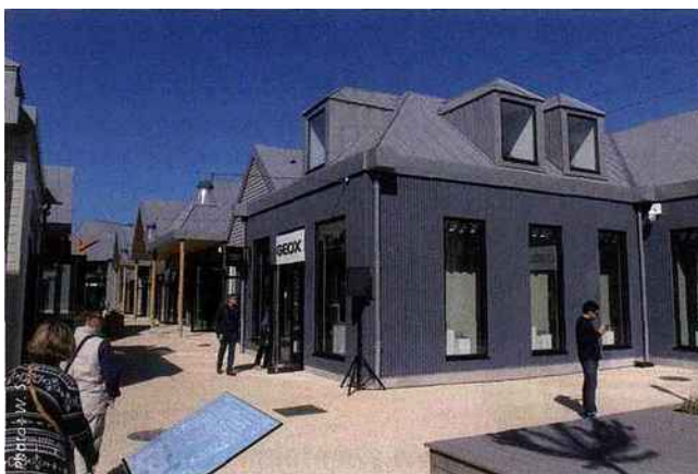
▲ Reprenant les codes architecturaux de la cote Est des Etats-Unis, le village Marques Avenue A13 est présente comme la vitrine de la nouvelle génération de centres commerciaux de l'enseigne
