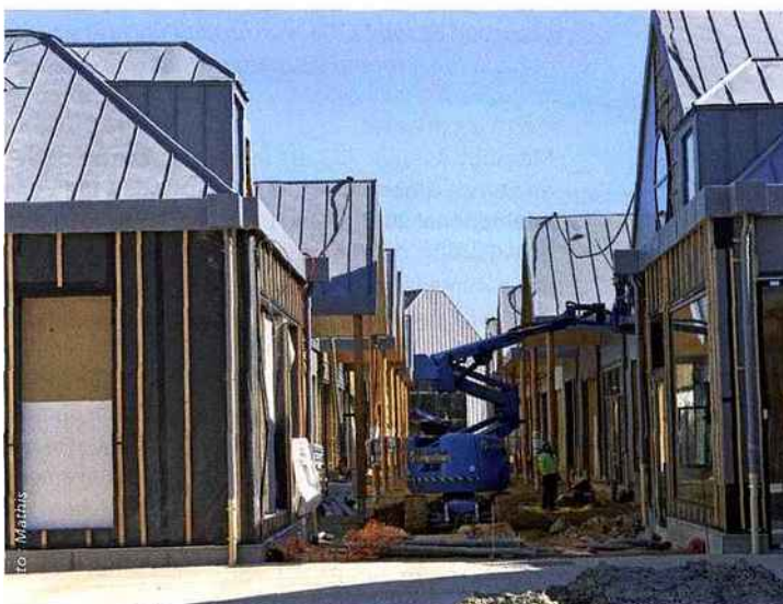
▲ De 2,45 m de largeur, les murs atteignent des hauteurs de 5 à 11 m
