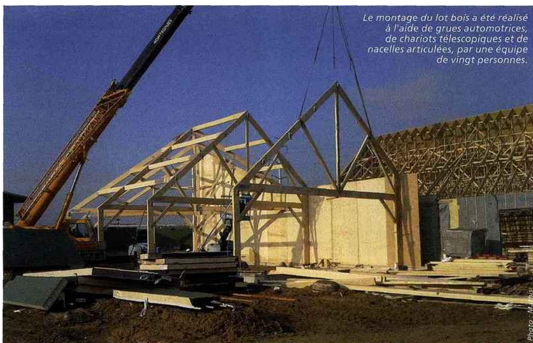
Si, dans la plupart des bâtiments, la charpente est réalisée avec des fermettes, certains, de plus grande envergure, ont été recouverts avec une charpente en lamellé-collé.
