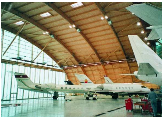
Le hangar pour Boeing 747 Aéroport de Bâle en Suisse
