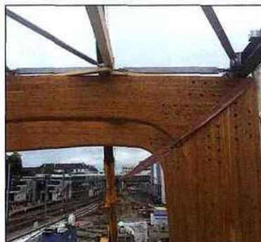
Confectionnées sur-mesure, les pièces hors-norme de la charpente en bois douglas ont nécessité deux à trois recollages pour obtenir des épaisseurs de 30 cm pour les portiques et de 60 cm pour le boomerang : l'épaisseur maximale requise étant en général de 21 cm ■
