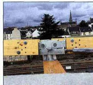
Inserée dans le bois, la ferrure spécifique en acier galvanisé et en forme de nœud, qui est dotée de rondelles, d'un tube métallique et d'ailettes de renfort, permet de connecter une traverse à une panne. Elle s'ajuste à chaque cas de figure, sans aucun jeu possible. ■
