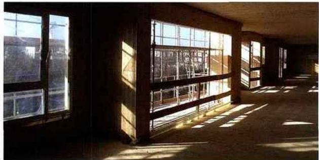
▲ Un étage en structure bois représente trois camions de murs CLT, neuf camions de planchers, un camion de charpente lamellée-collée et 6 jours de pose.
